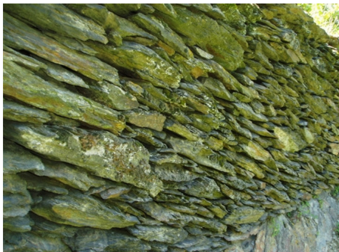
Sans doute ce sont les moines qui les premiers ont érigé ces murets savamment et magnifiquement construits
